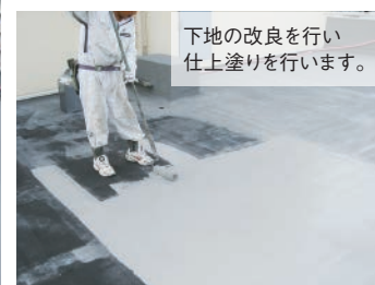
シート防水では、ジョイント部はより丁寧に作業を行います。
